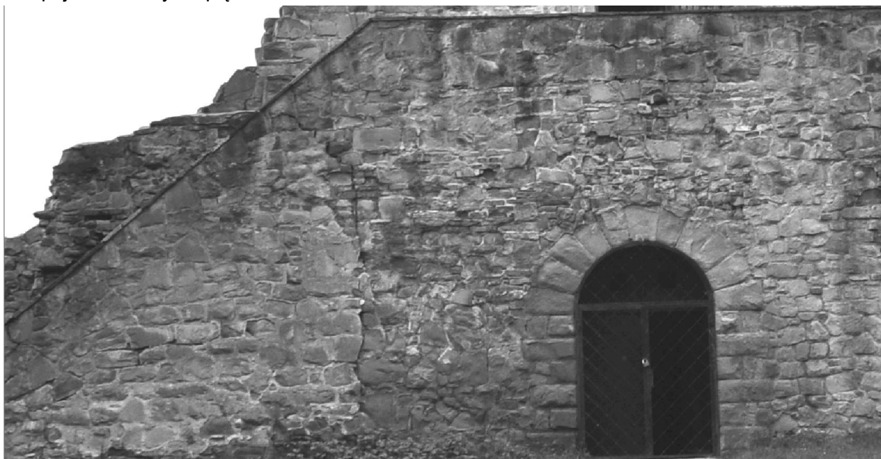
Odspojone schody na piętro – szczelina ok. 15-20mm
