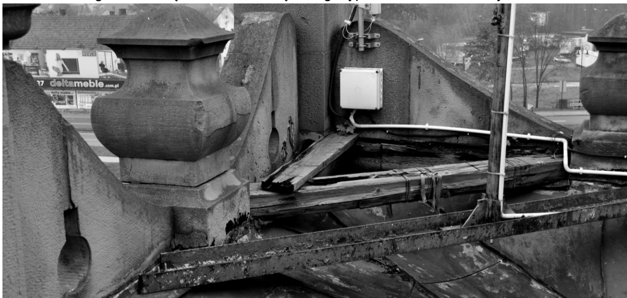
Odspojone schody na piętro – szczelina ok. 15-20mm
